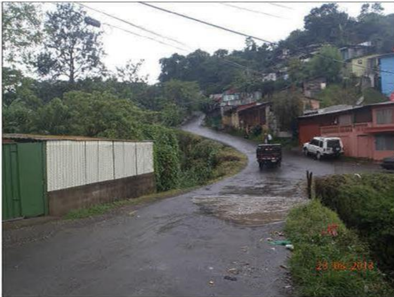
Antes de la intervención
