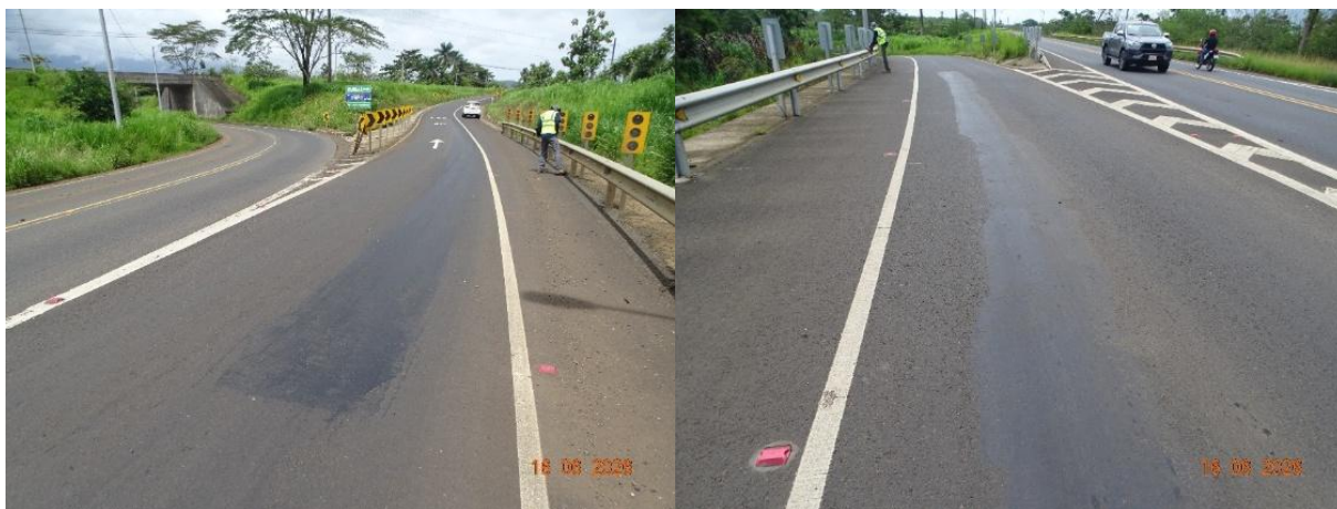
Figura 24. Exceso de asfalto en la superficie, riesgo de superficie lisa. Fecha: 16 de junio de 2026. Fuente: LanammeUCR.
