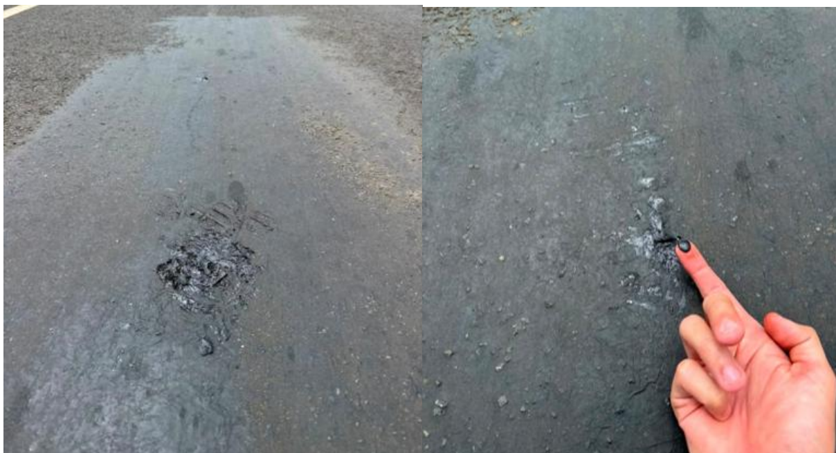
Figura 24. Exceso de asfalto en la superficie, riesgo de superficie lisa. Fecha: 16 de junio de 2026. Fuente: LanammeUCR.
