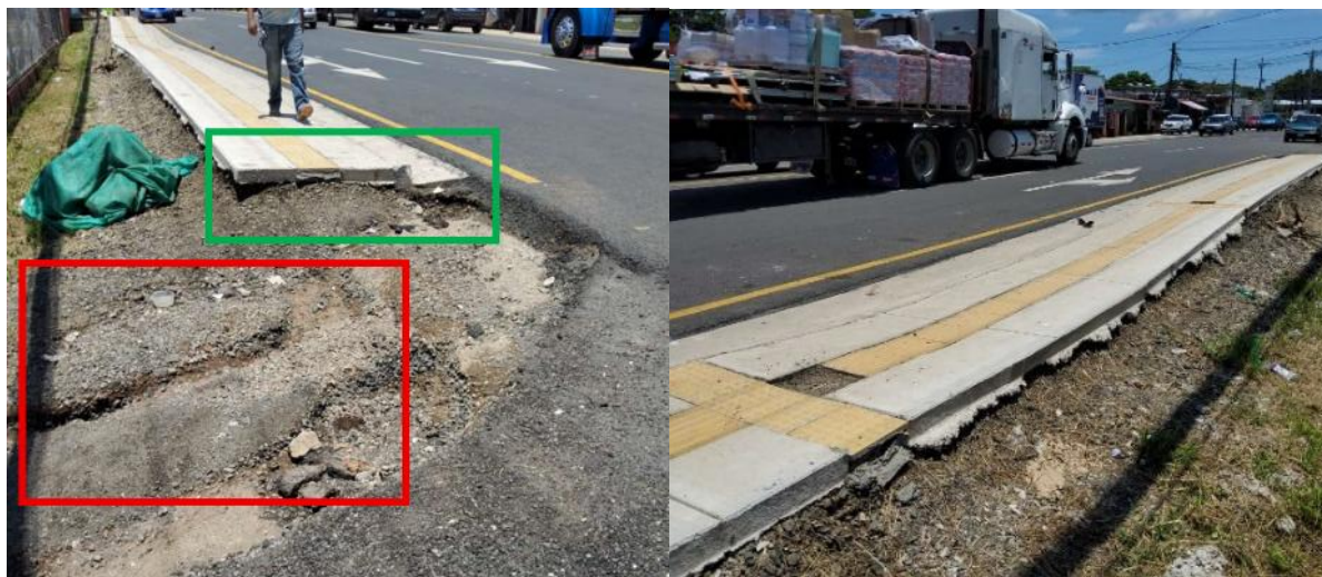
Figura 25. Infraestructura peatonal, acera frente a salón comunal de Huacas. Fotografía del 12 de agosto de 2025. Fuente: LanammeUCR
