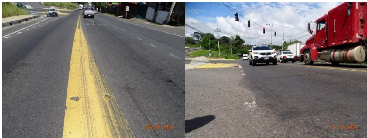
Figura 9. Evolución de agrietamiento por fatiga. Intersección de acceso de General Cañas hacia Lagunilla Ruta Nacional N.º 106. Fecha: 5 de septiembre de 2023 – 17 de octubre de 2025. Fuente: LanammeUCR
