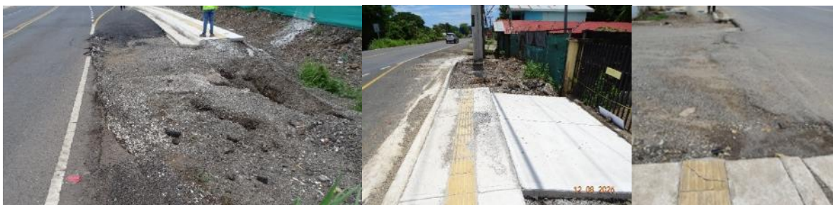
Figura 27. Interrupción de infraestructura peatonal en ambos márgenes de la carretera sobre Ruta Nacional 180. Fotografía del 12 de agosto de 2025. Fuente: LanammeUCR
