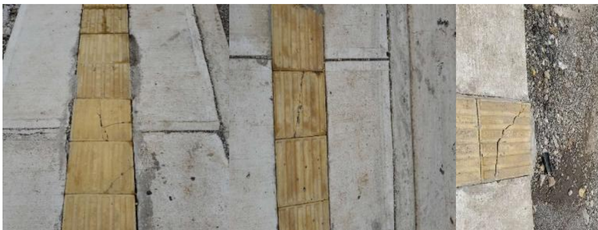
Figura 30. Sitios con peligro de caída. Fotografías del 9 de septiembre de 2025. Fuente: LanammeUCR
