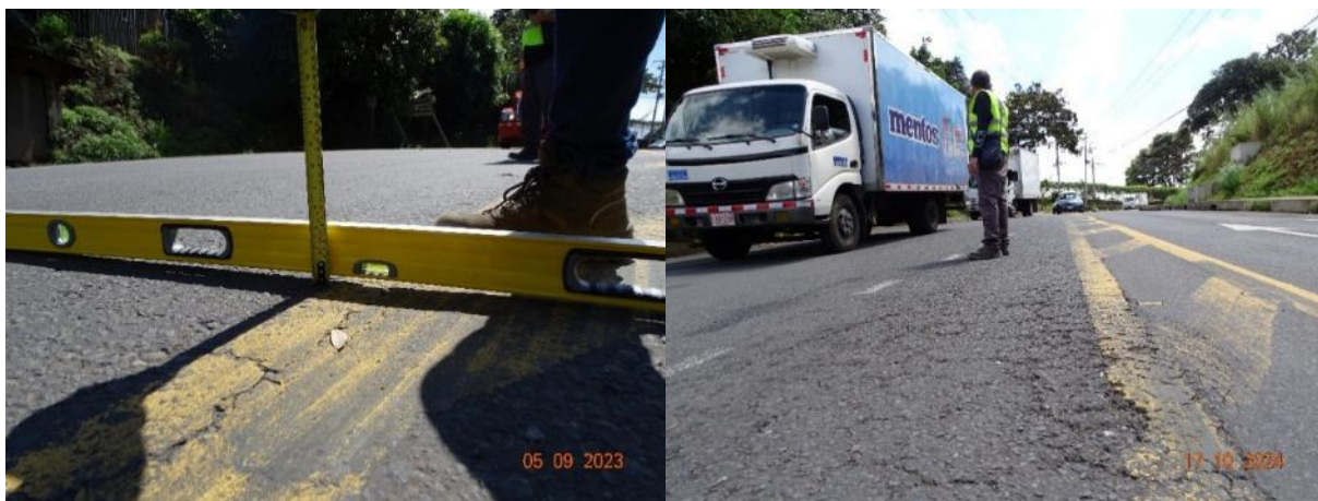
Figura 9. Evolución de agrietamiento por fatiga. Intersección de acceso de General Cañas hacia Lagunilla Ruta Nacional N.º 106. Fecha: 5 de septiembre de 2023 – 17 de octubre de 2025. Fuente: LanammeUCR
