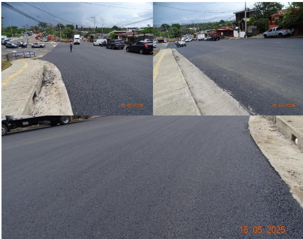
Figura 14. Obras de conservación vial en carriles previamente intervenidos en el proyecto de obra nueva: Lote 01 OBIS, Conector Barreal–Castella. Ruta Nacional N.º 106. Fecha: 15 de mayo de 2025. Fuente: LanammeUCR
