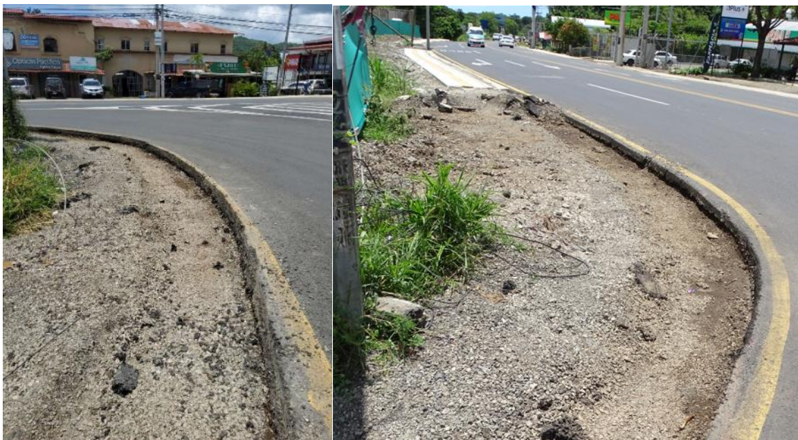
Figura 27. Interrupción de infraestructura peatonal en ambos márgenes de la carretera sobre Ruta Nacional 180. Fotografía del 12 de agosto de 2025. Fuente: LanammeUCR
